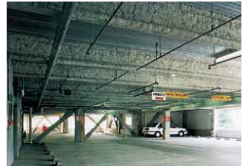
一般鋼に耐火被覆を施した駐車場の例
